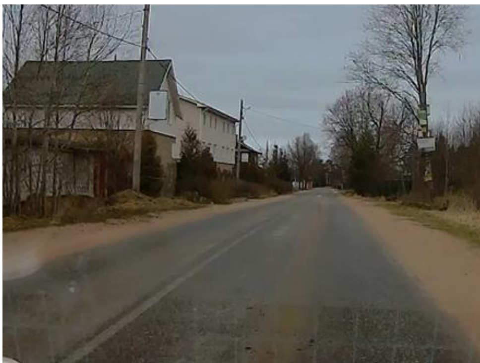
Рисунок 2.7.2.6 – Несоответствие разметки 1.1 требованиям п.5.1.15 ГОСТ 32953-2014 (дер. Назия)
