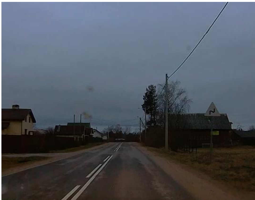
Рисунок 2.7.1.9 – Эксплуатационное состояние 1.12.1 «Опасные повороты» не соответствует требованиям ГОСТ Р 50597-2017 (д. Горная Шальдиха, Путиловское сельское поселение)
