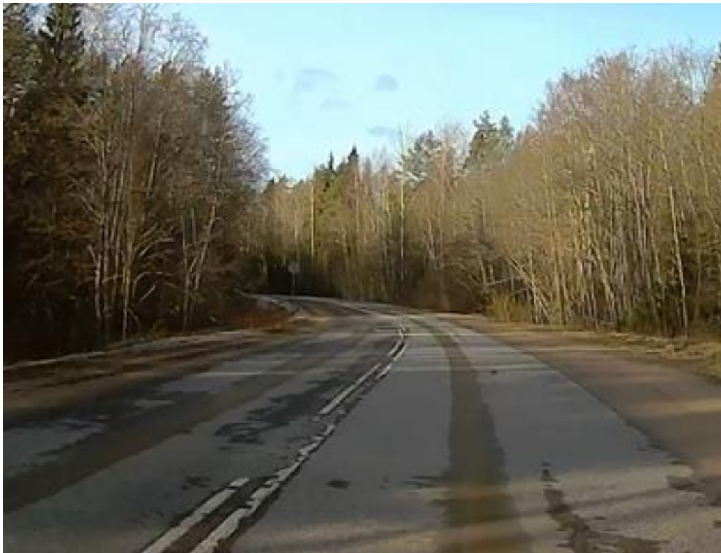
Рисунок 2.7.2.3 – Несоответствие разметки 1.3 требованиям п.5.1.15 ГОСТ 32953-2014 (а/д 41К-122)
