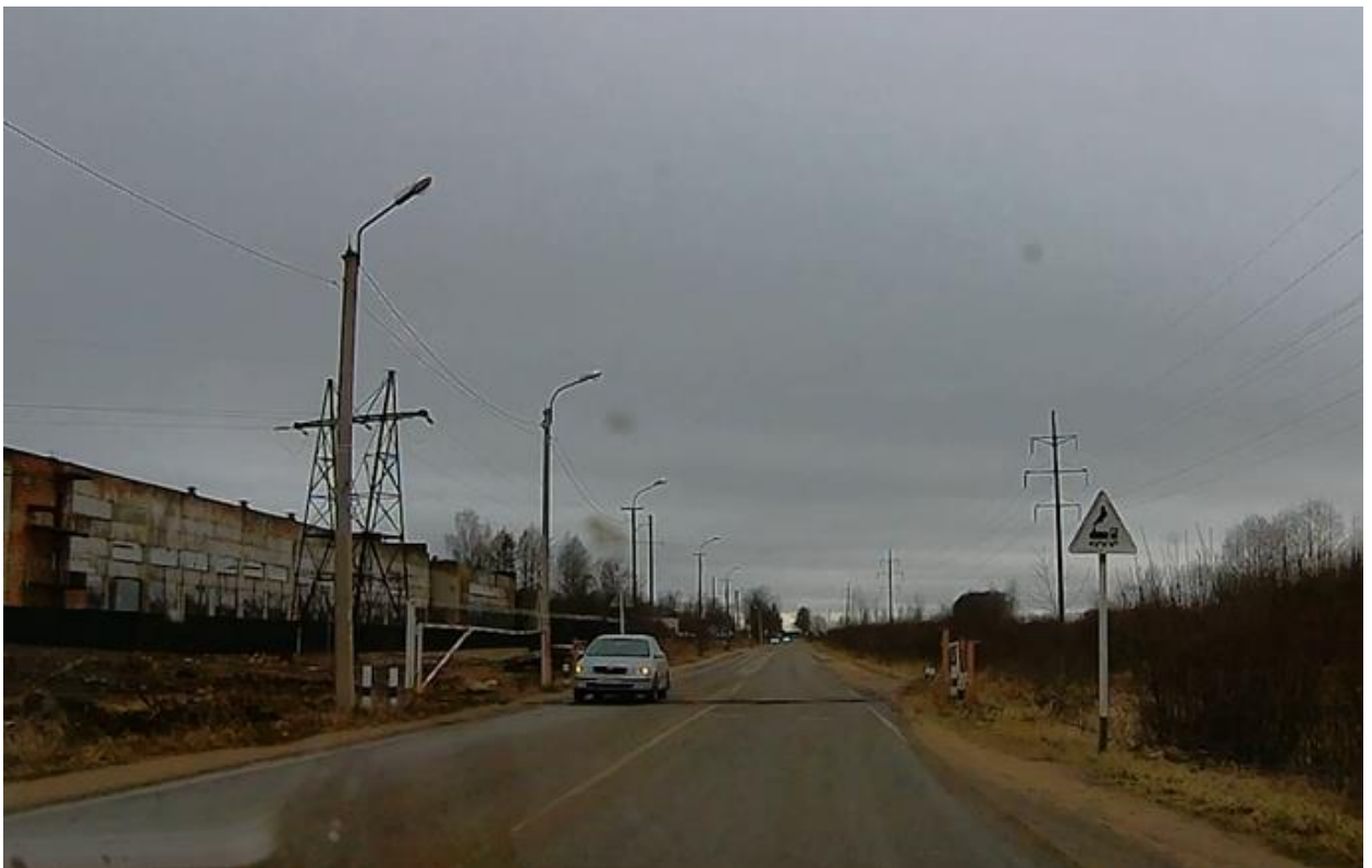
Рисунок 2.7.1.6 – Эксплуатационное состояние 1.2 «Железнодорожный переезд без шлагбаума» не соответствует требованиям ГОСТ Р 50597-2017 (пгт. Назия)
