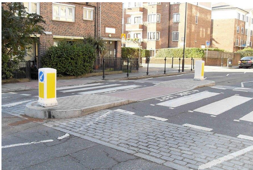
Рисунок 2.5.2.4 – Островок безопасности на пешеходном переходе
