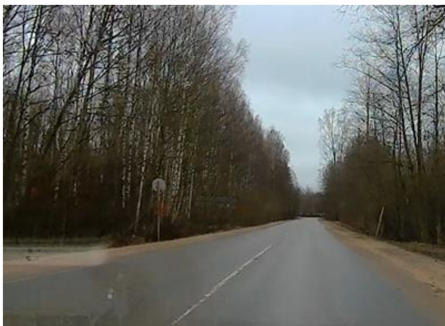
Рисунок 2.7.2.2 – Несоответствие разметки 1.2 требованиям п.5.1.15 ГОСТ 32953-2014 (а/д 41К-004)
