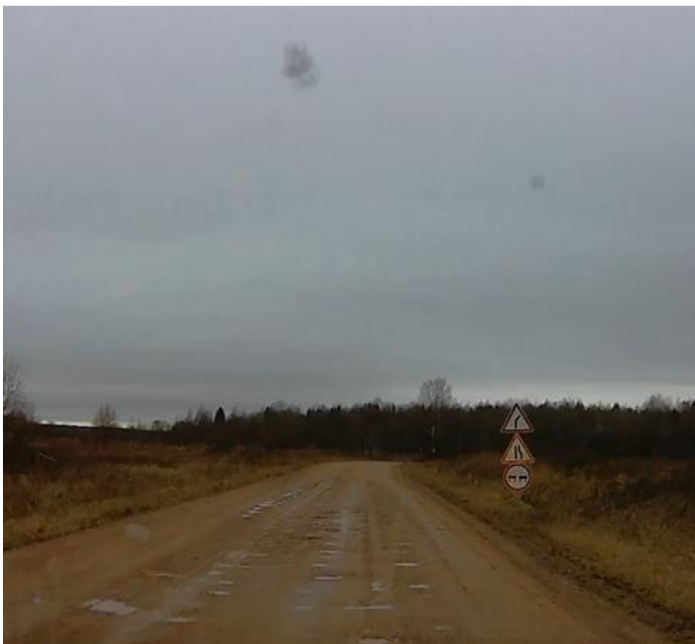
Рисунок 2.7.1.1 – Высота установки знаков 1.11.1 «Опасный поворот», 1.20.2 «Сужение дороги», 3.22 «Обгон запрещен» не соответствует требованиям ГОСТ Р 52289-2019 (а/д 41К-121)
