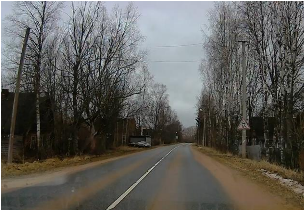
Рисунок 2.7.1.7 – Эксплуатационное состояние 1.15 «Скользкая дорога» не соответствует требованиям ГОСТ Р 50597-2017 (д. Ратница, Шумское сельское поселение)
