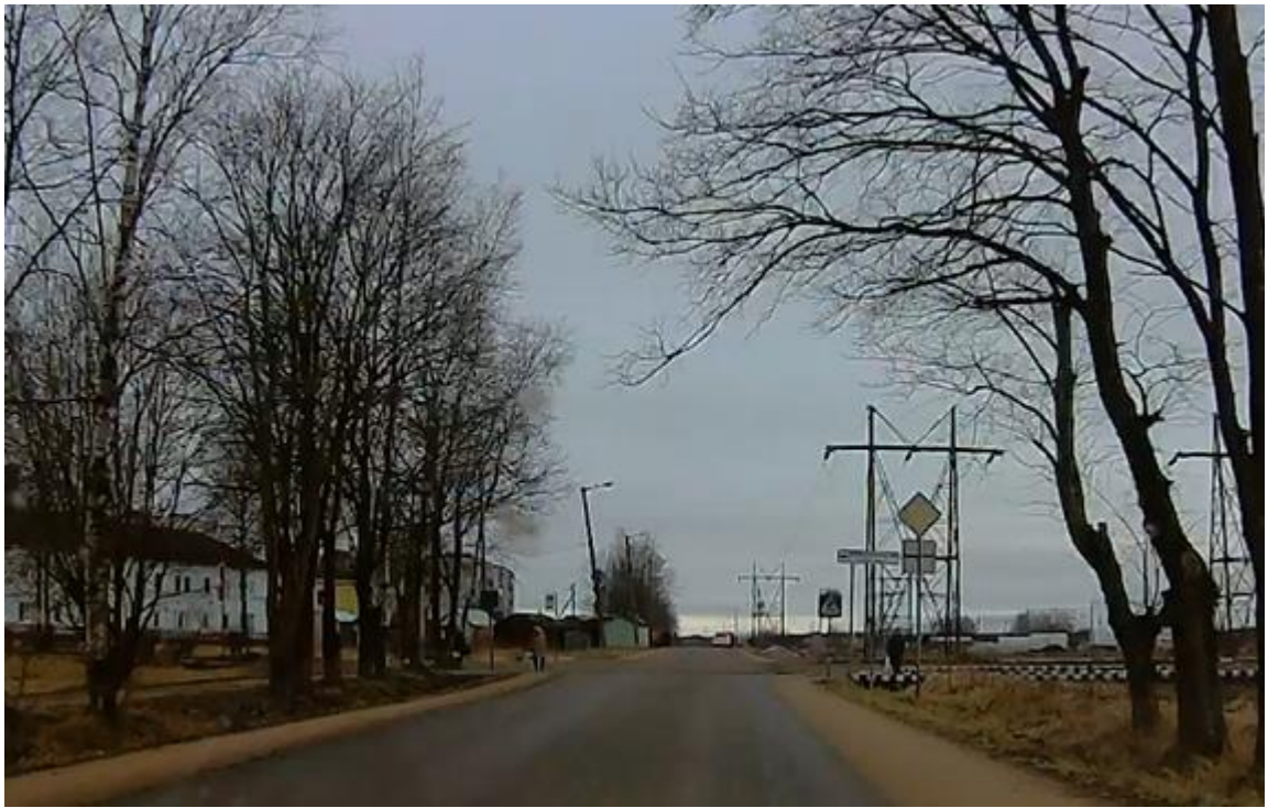
Рисунок 2.7.1.5 – Эксплуатационное состояние 2.1 «Главная дорога» не соответствует требованиям ГОСТ Р 50597-2017 (пгт. Назия)
