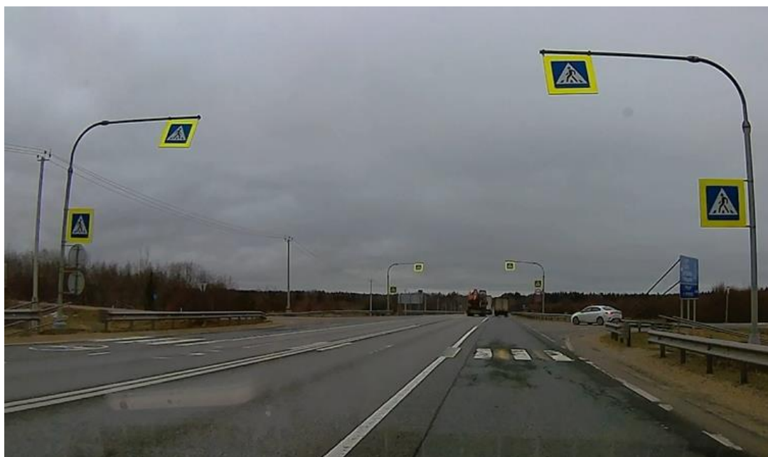
Рисунок 2.7.2.1 – Несоответствие разметки 1.14.1 требованиям п.5.1.15 ГОСТ 32953-2014 (трасса Р-21 «Кола», Шумское сельское поселение)
