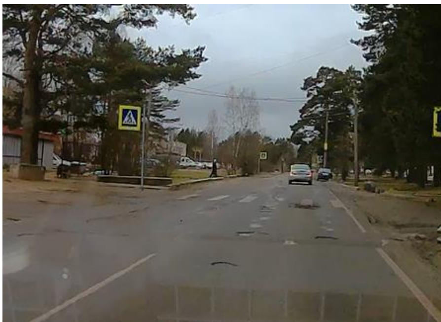
Рисунок 2.7.2.5 – Несоответствие разметки 1.1, 1.2 и 1.14.1 требованиям п.5.1.15 ГОСТ 32953-2014 (пгт. Приладожский)
