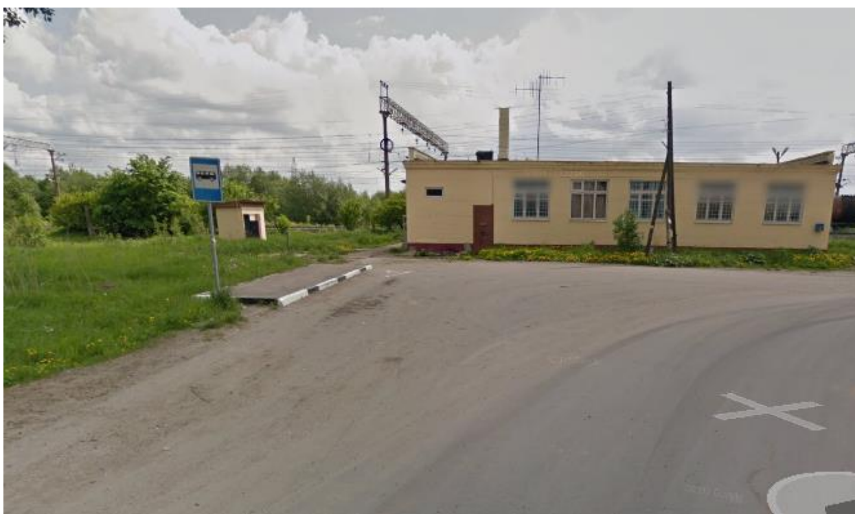
Рисунок 2.5.2.3 – Отсутствие тротуара на подходе к остановочному пункту д. Войбокало, Шумское сельское поселение)
