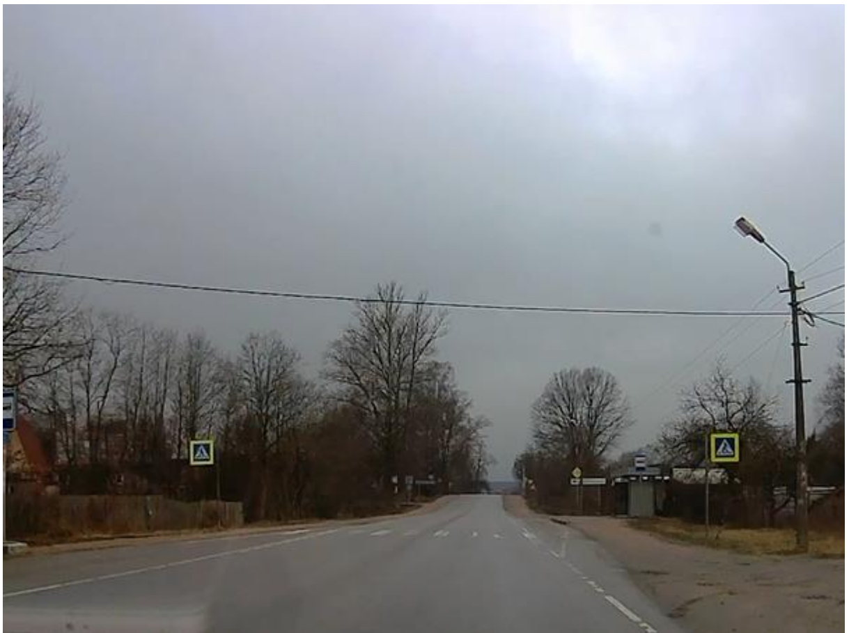
Рисунок 2.7.2.4 – Несоответствие разметки 1.2 и 1.14.1 требованиям п.5.1.15 ГОСТ 32953-2014 (пгт. Павлово)
