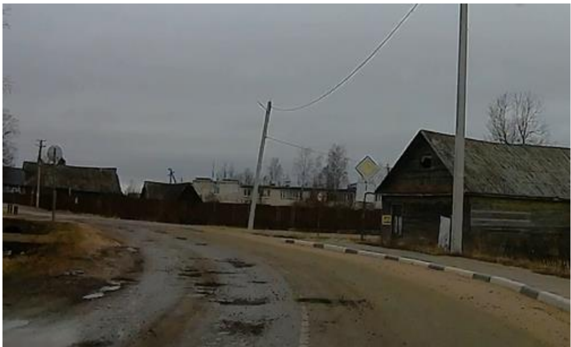
Рисунок 2.7.1.8 – Эксплуатационное состояние 2.1 «Главная дорога» не соответствует требованиям ГОСТ Р 50597-2017 (с. Шум)
